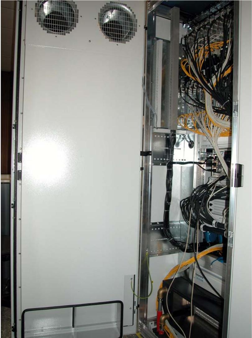
**Bild 4: Wassergekühlter Schrank der Firma Knürr, Rückseite**
