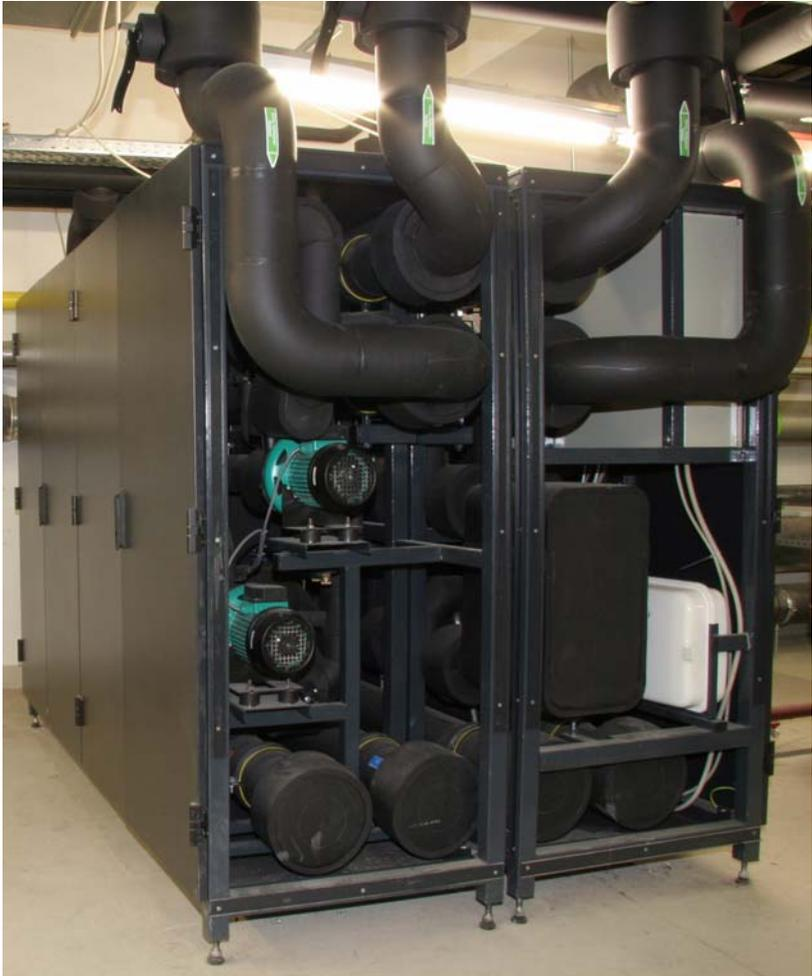
**Bild 9: Zwei Wasser-Wasser-Wärmetauscher mit je 100 kW Leistung erzeugen das 12° C kalte Kühlwasser für die Serverschränke.**
