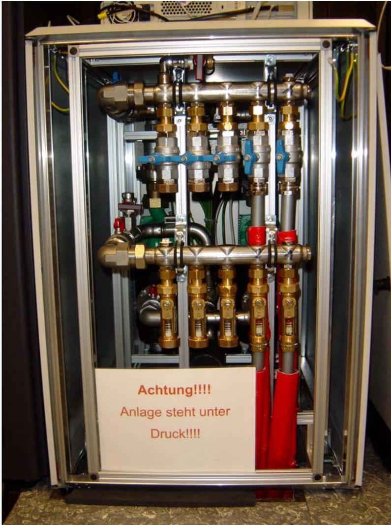
**Bild 6: Wasser-Wasser-Wärmetauscher (CTU) mit 75 kW Leistung**
