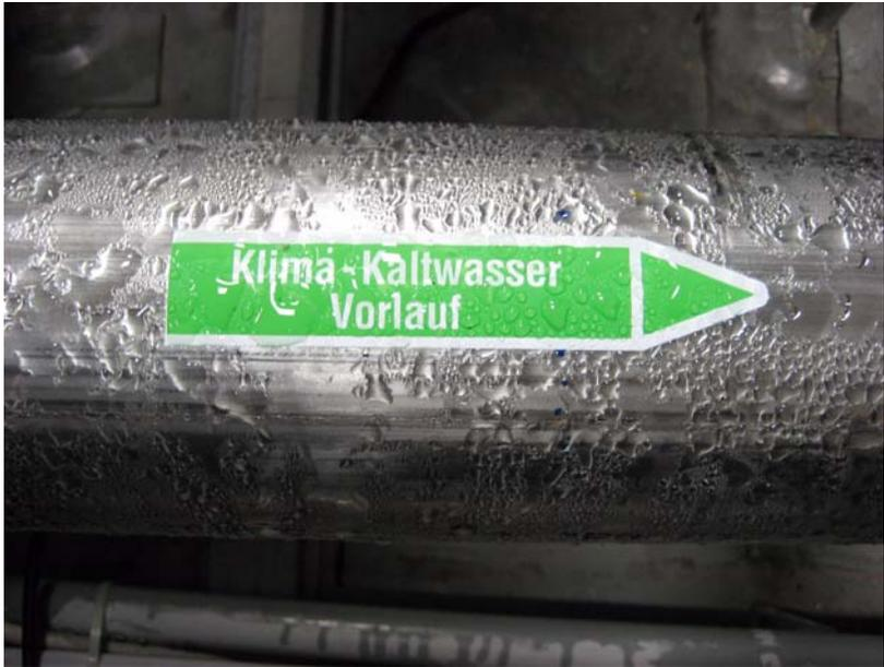
**Bild 11: Kondenswasserbildung an den Kaltwasserrohren durch falsch installierte Feuchtefühler**
