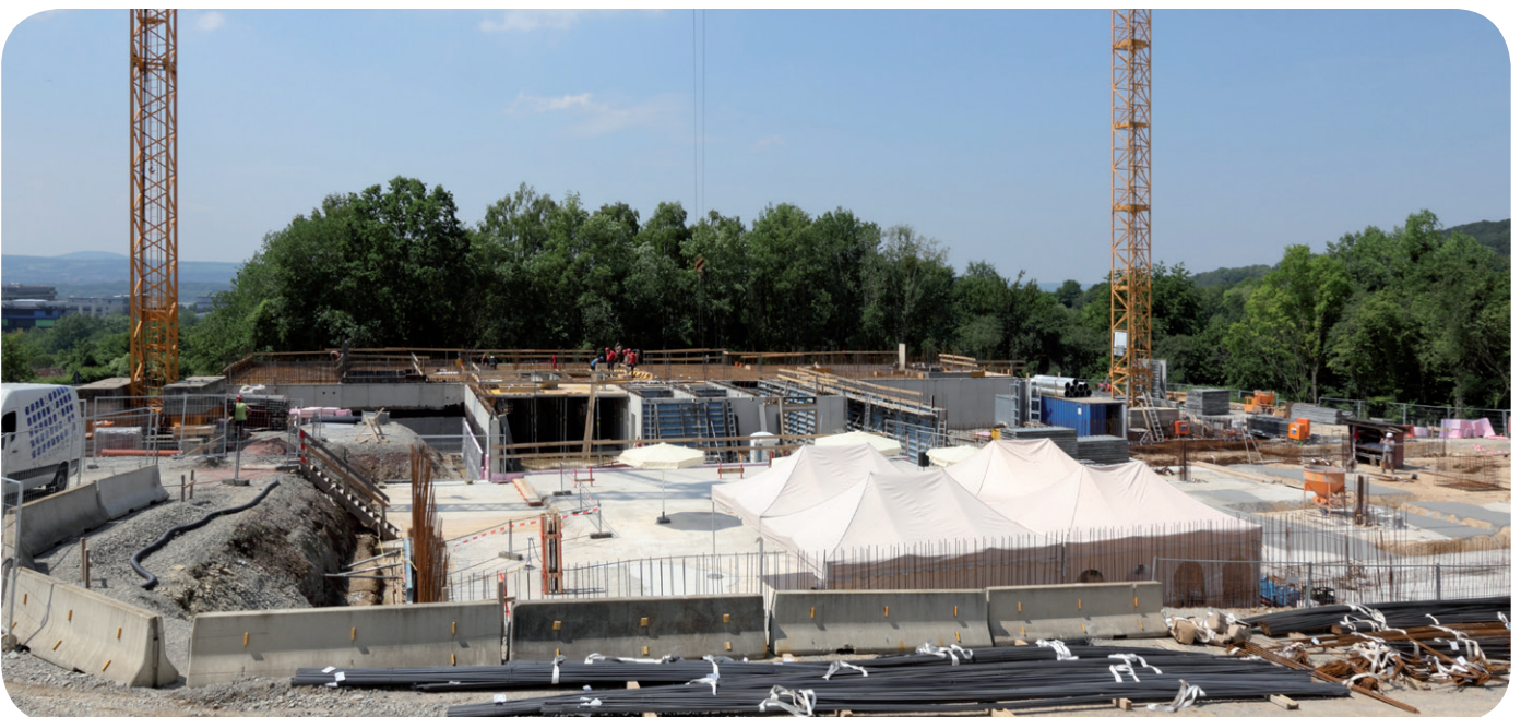
Blick über die Baustelle des gemeinsamen Rechenzentrums auf dem Nordcampus der Universität Göttingen (Aufnahme am Tag der Grundsteinlegung)
